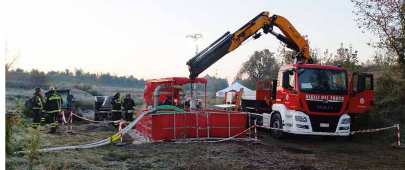
■ Sito di Halda Hrabova. Vista dell'area di lavoro: zona aspirazione e vasca di disconnessione
