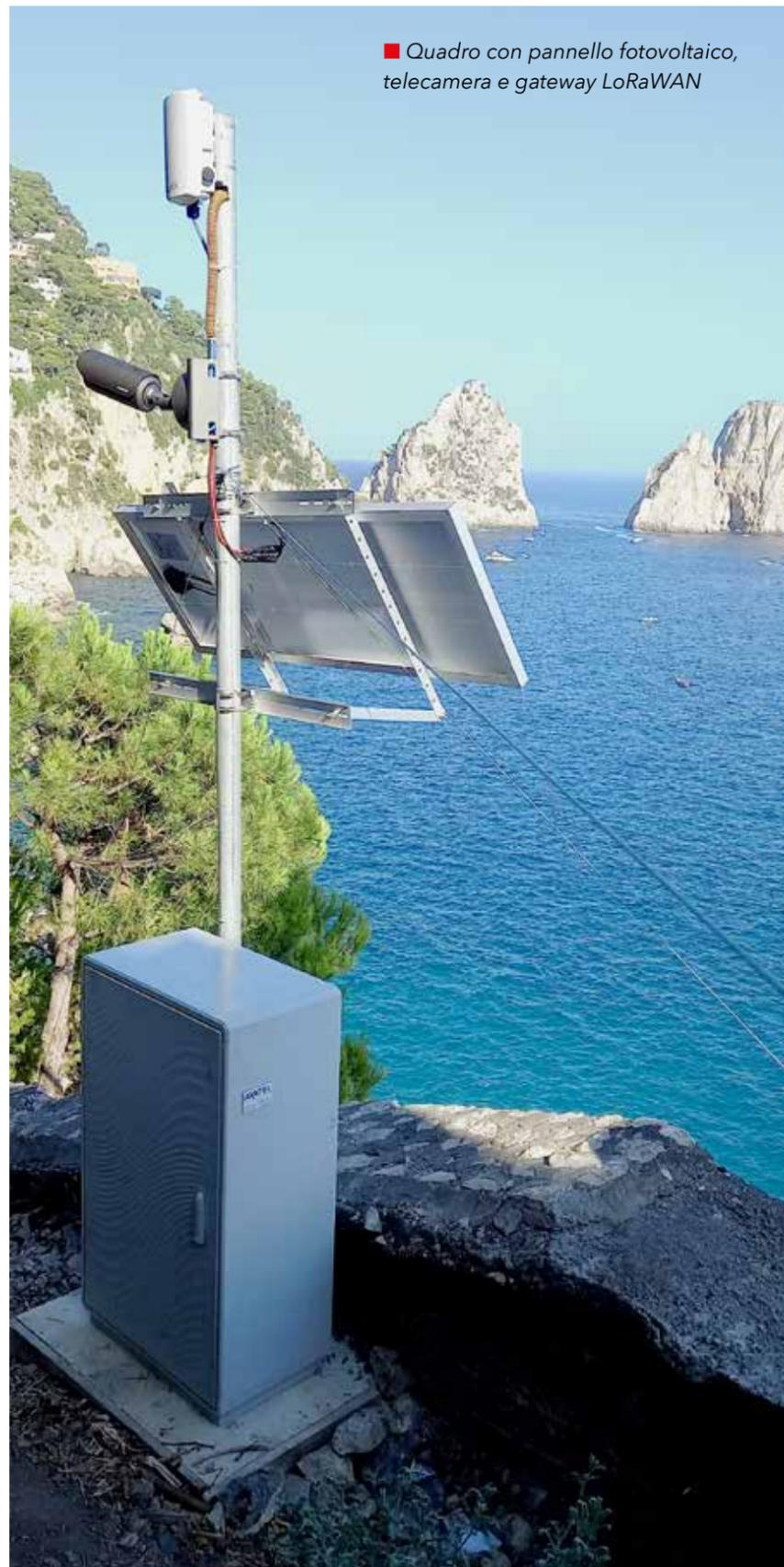
■ Quadro con pannello fotovoltaico, telecamera e gateway LoRaWAN
